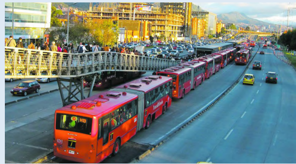
Figura 26: Estação do Transmilenio em Bogotá, na Colômbia, 2014.
