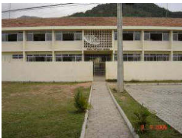
Figura 40 – Portão principal de entrada da Escola Básica Municipal Luiz Cândido da Luz
