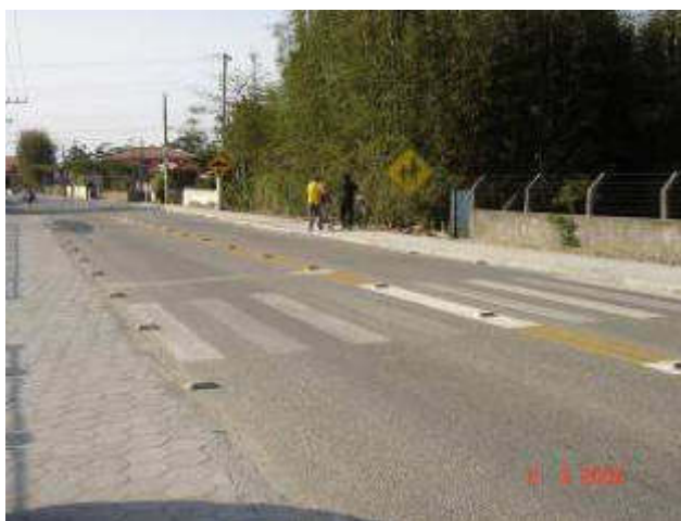
Figura 14 – Vista Rodovia defronte a Escola Básica Municipal Dilma Lúcia dos Santos
