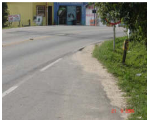
Figura 51 – Acostamento da Escola Básica Municipal Porto do Rio Tavares
