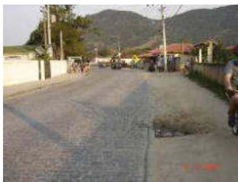
Figura 1 – Vista 1 - Escola Básica Municipal Batista Pereira
