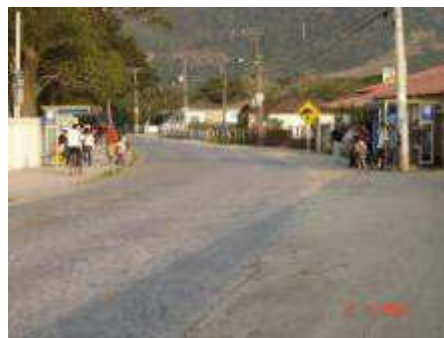
Figura 4 – Vista 3 - Escola Básica Municipal Batista Pereira
