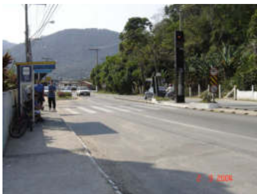
Figura 52 – Vista 1 - Calçada defronte a Escola Básica Municipal Porto do Rio Tavares
