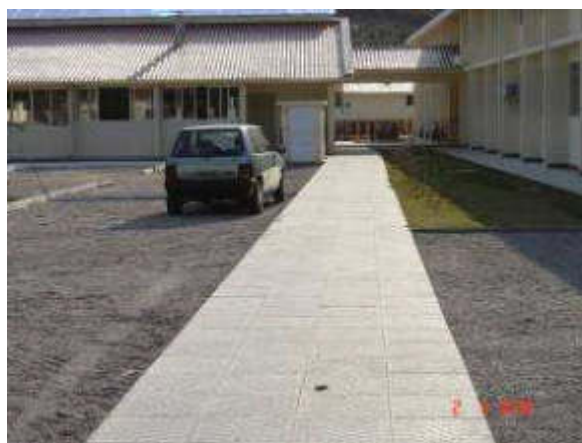
Figura 12 - Vista 5 - Interior da Escola Básica Municipal Dilma Lúcia dos Santos
