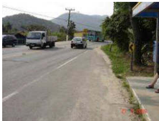
Figura 55 - Vista 2 - Calçada defronte a Escola Básica Municipal Porto do Rio Tavares
