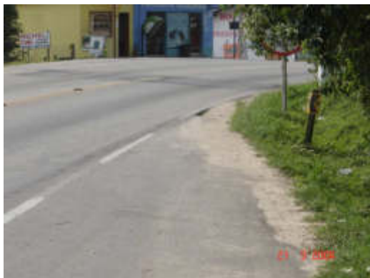
Figura 54 - Vista 1 - Calçada defronte a Escola Básica Municipal Porto do Rio Tavares
