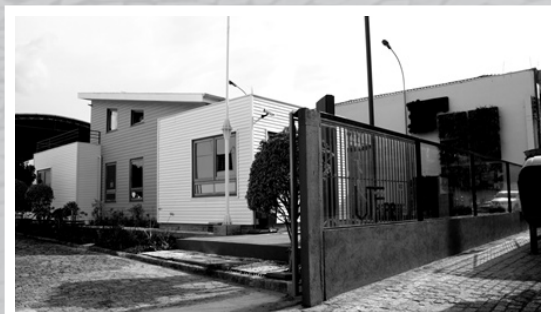
Ponto Intermediário - Vista Geral Escritório Verde UTFPR - Universidade Tecnológica Federal do Paraná
