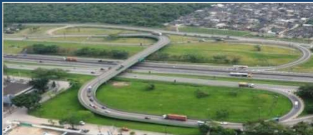
Remodelação do Viaduto 31 de Março
