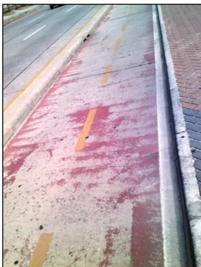
Figura 18: Pintura da pista desgasta no asfalto. Trecho: Avenida Boa Viagem. Fonte: Dados da pesquisa (M.D.INÁCIO, 2013).
