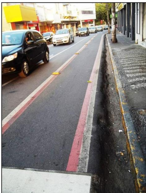
Figura 45: Pintura de demarcação da ciclofaixa em bom estado de conservação. Trecho: Estrada do Arraial. Fonte: Dados da pesquisa (M.D.INÁCIO, 2013).
