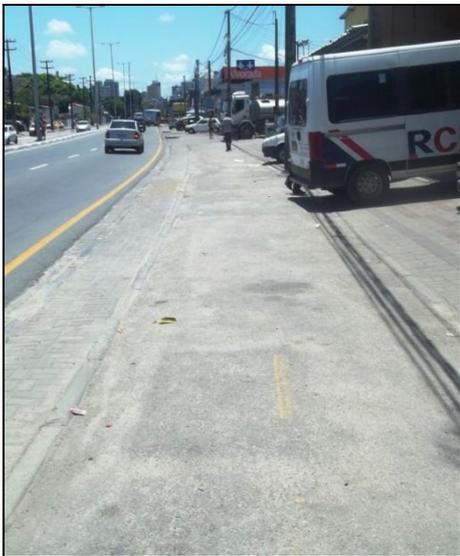
Figura 42: Pintura desgastada e inexistente. Trecho: Avenida Norte. Fonte: Dados da pesquisa (M.D.INÁCIO, 2013).
