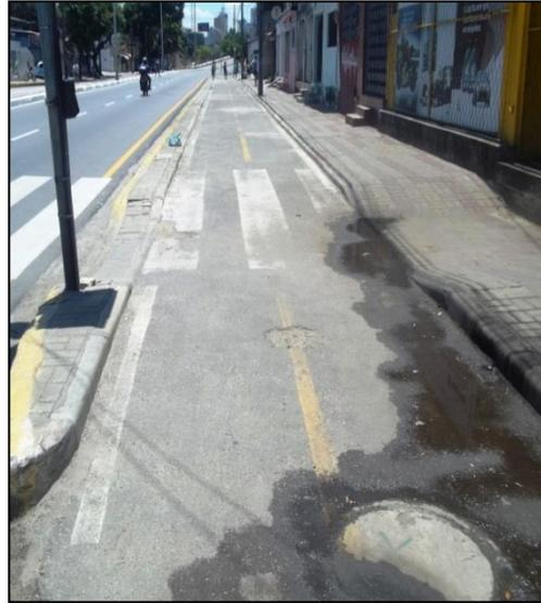
Figura 41: Desnível no pavimento com acúmulo de água. Trecho: Avenida Norte. Fonte: Dados da pesquisa (M.D.INÁCIO, 2013).
