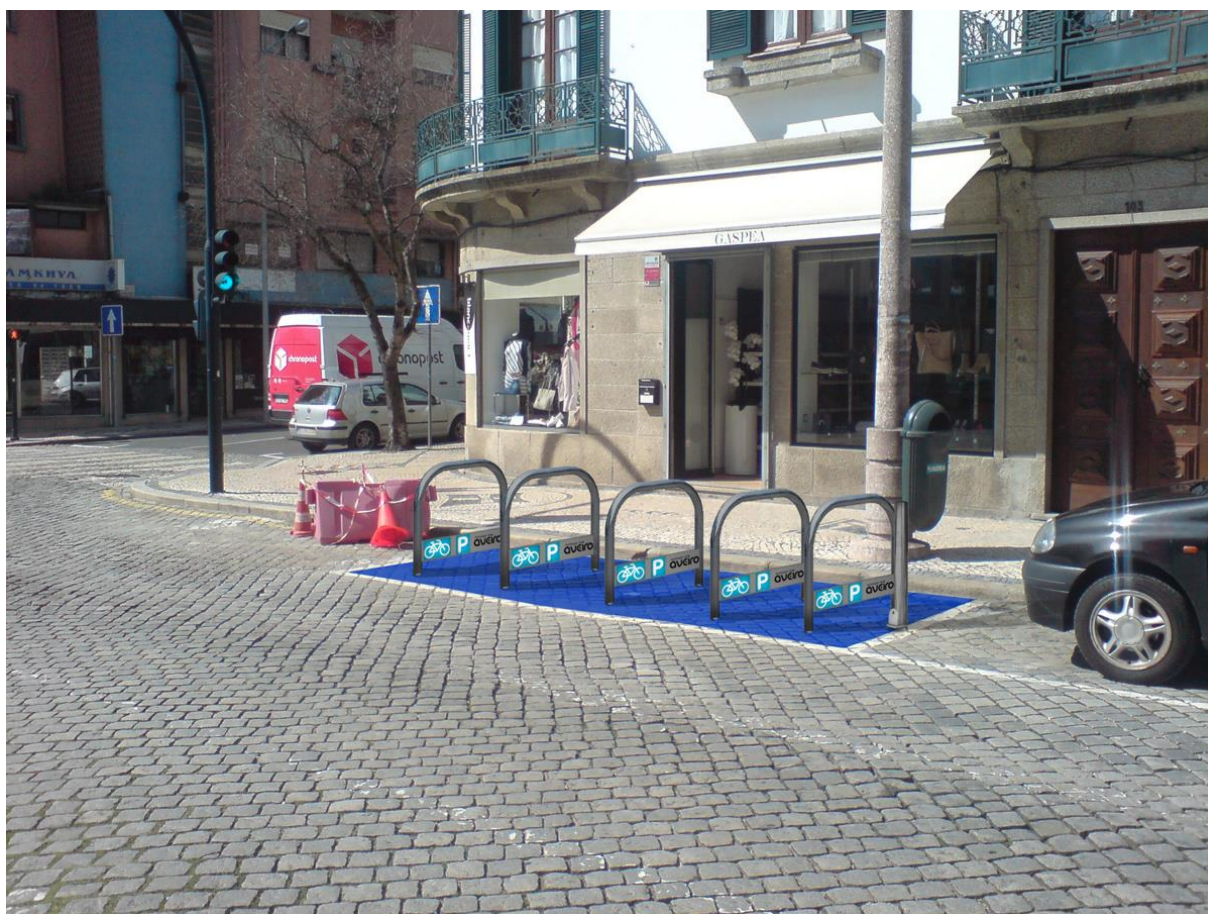
Fig. 10: Conversão de um lugar de estacionamento automóvel na Av. Dr. Lourenço Peixinho em estacionamento para dez bicicletas com suportes tipo Sheffield chumbados ao chão, com pintura do pavimento e delimitação física do espaço com pilarete.
