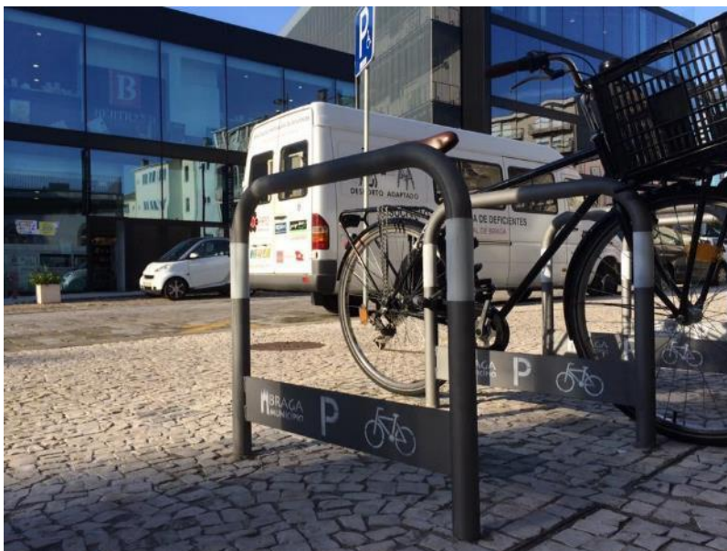
Fig. 8: Suportes tipo Sheffield com barra inferior de identificação para invisuais, chumbados ao chão.
