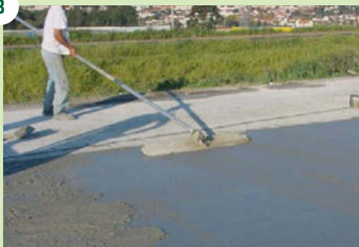
Nivelamento de superfície executado com auxílio de régua de corte e desempenadeira (floating) de cabo estendido e rótula.
