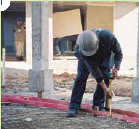
Fixação da fôrma de forma que o topo coincida com a superfície de rolamento prevista em projeto. Deve-se garantir espessura uniforme ao longo de todo o pavimento.
