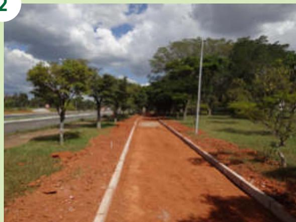
Colocação de guias premoldadas bem niveladas. Regularização e compactação do subleito.
