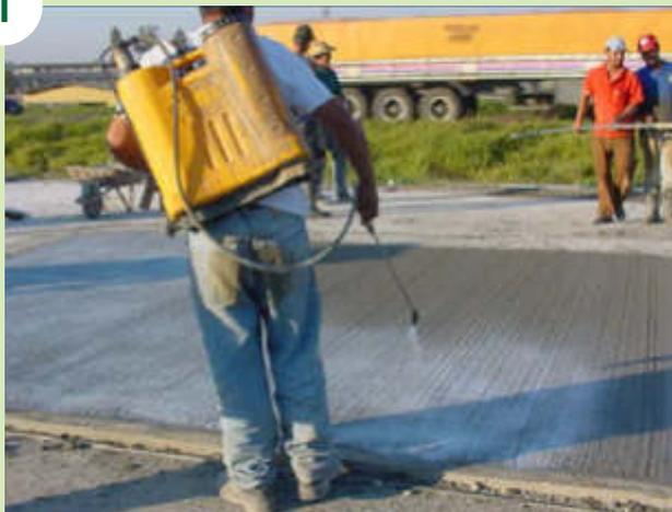
A aplicação do produto de cura pode ser manual, realizada com pulverizadores costais. Após a aplicação do produto, a área do pavimento deve ser protegida para que a superfície do concreto fresco não seja danificada pela circulação precoce de pessoas e bicicletas.
