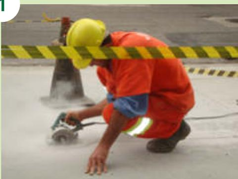
O Projeto Executivo de Engenharia deve prever juntas transversais de retração e de construção. Estas devem ser serradas com serra de disco diamantado, assim que o concreto aceitar o corte sem se danificar. A profundidade do corte deve ser especificada.
