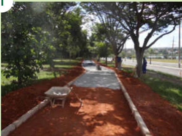
Distribuição da camada granular uniformemente sobre o solo compactado. O material deve estar limpo e bem graduado.
