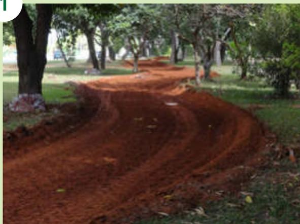
Abertura da caixa, com profundidade mínima de 20 cm e inclinação igual ao do pavimento acabado.
