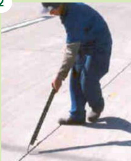
Após o corte das juntas, procede-se à limpeza com ferramentas com ponta cinzelada, que penetre na ranhura das juntas, e jateamento de ar comprimido.
