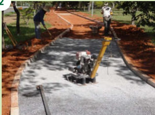
Após a distribuição dos grãos, a camada deve ser compactada, com placa ou rolo vibratório.
