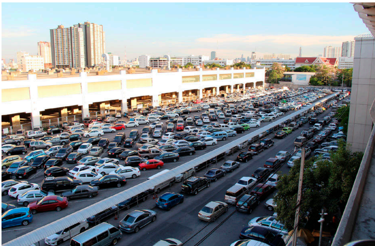
Figura 23: Estacionamento fora da rua em Bangcoc. © Vedant Goyal, 2013
