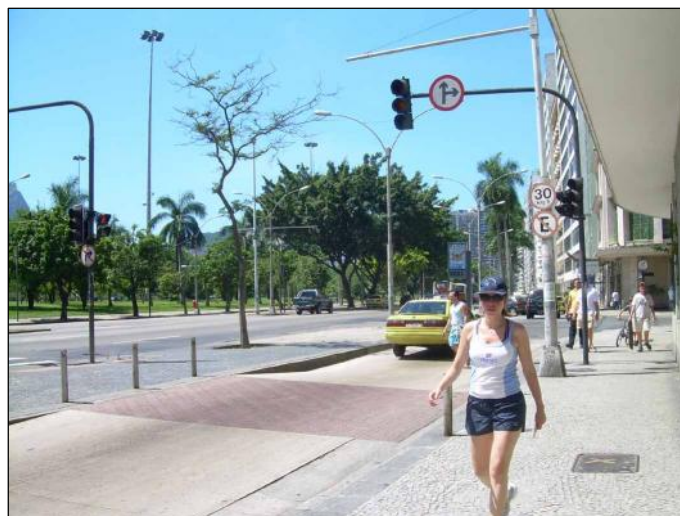
Figura 2.13 – Lombada Elevada, Flamengo, RJ
