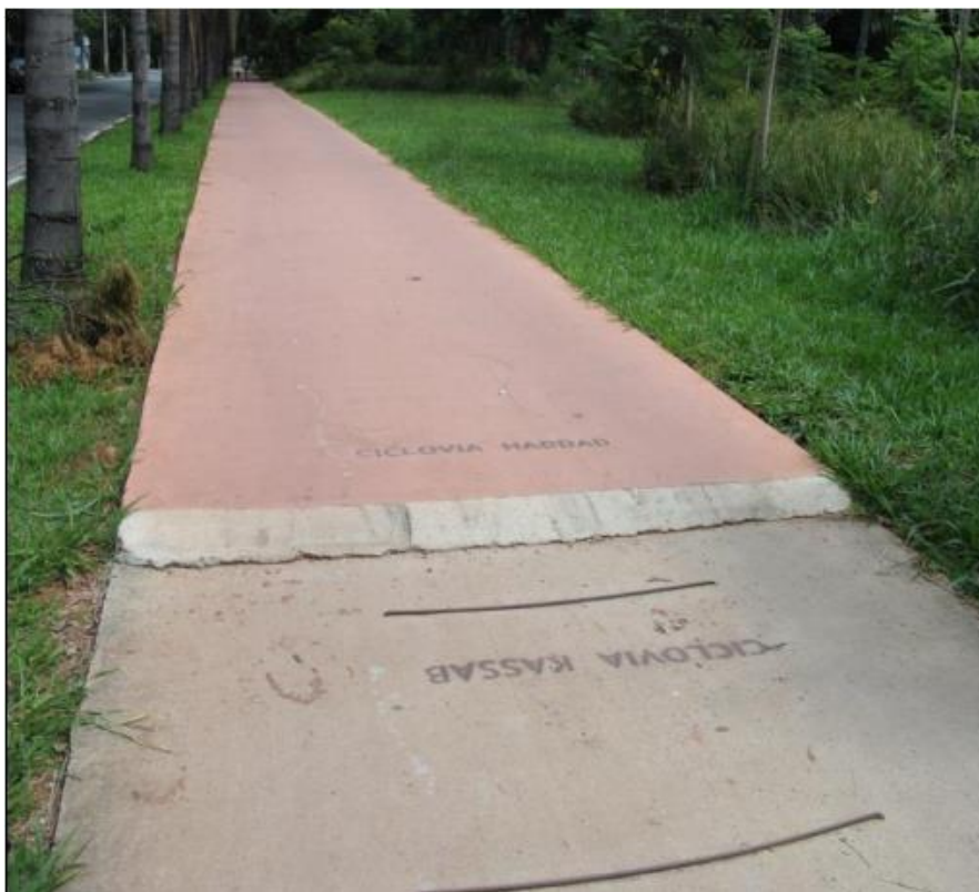
Figura 20: Ciclovía Avenida Prof. Fonseca Rodrigues destacado em documento de ação do MPSP
