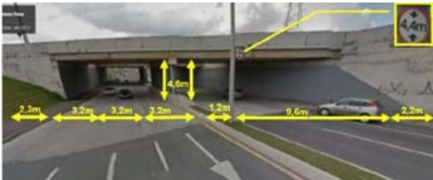
Figura 9 – Município de São José dos Pinhais - Trincheira Av. das Torres com Av. Rui Barbosa
