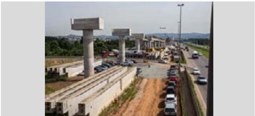
FIGURA 3 – Construção da estrutura elevada de trem em Guarulhos
