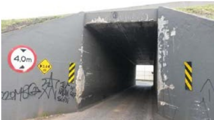
Figura 10 – Município de Colombo - Trincheira da rua Dezenove de Novembro com a BR 476
