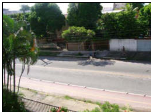
Figura 5.11: Ciclovía Tiradentes, na zona oeste do Recife. Fonte: Própria, 2009.
