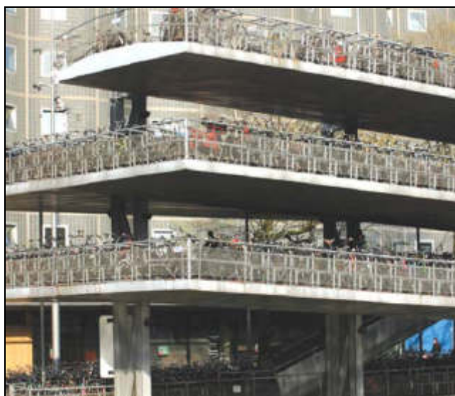
Figura 4.8: Estacionamento para bicicletas na Estação Central de Amsterdã, Holanda. Fonte: SPICYCLES, 2009.
