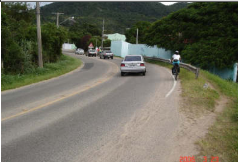
Figura 12: Curva perigosa sem acostamento na Av. Osni Ortiga (Foto da autora)
