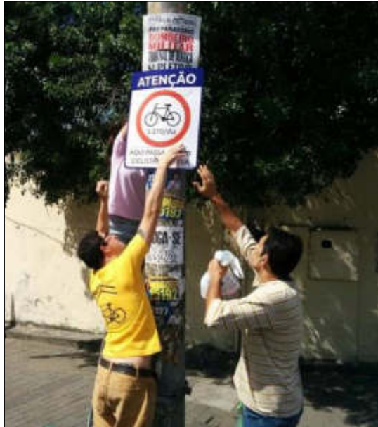
Figura 6 – Instalação de Placas
