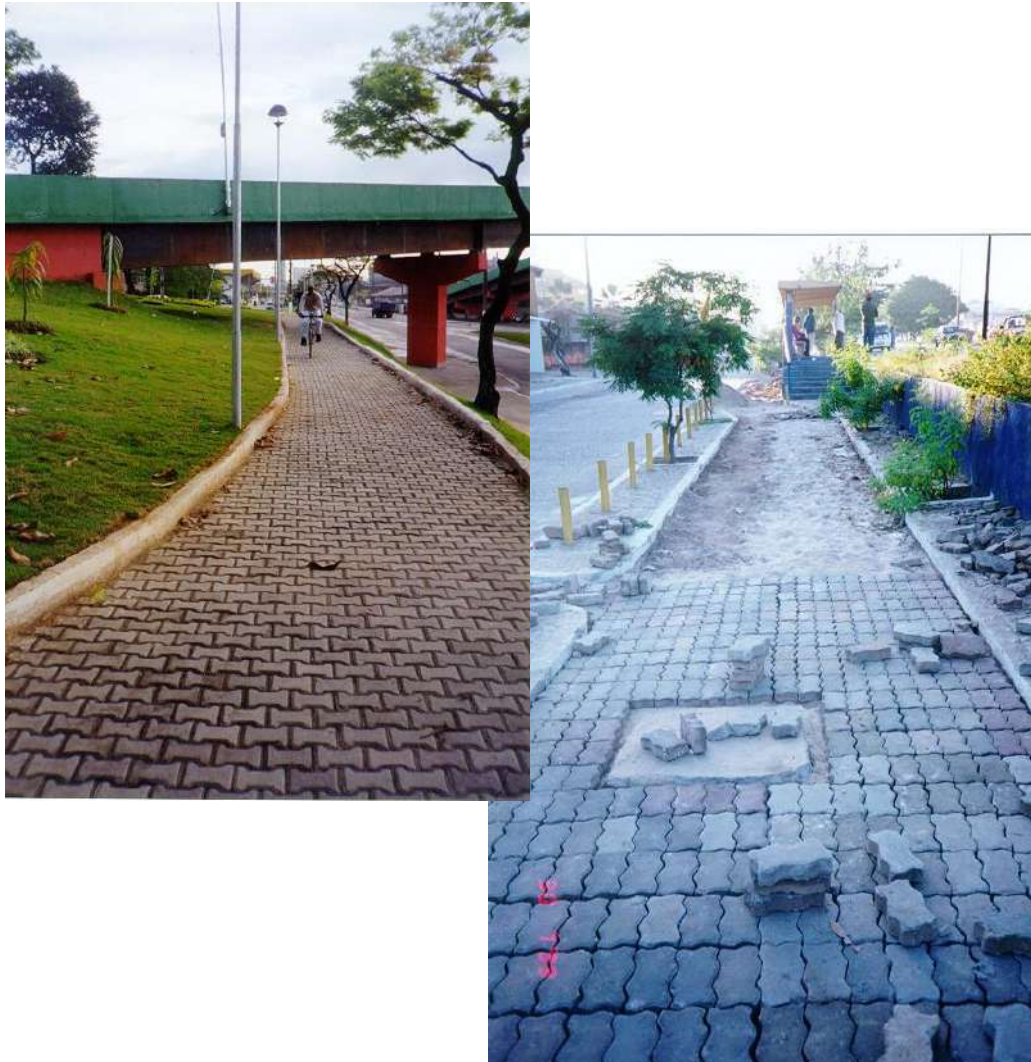
FIGURA 48 PAVIMENTOS DE CICLOVIAS COM BLOCOS PRÉ-MOLDADOS EM VOLTA REDONDA/RJ E TERESINA/PI
