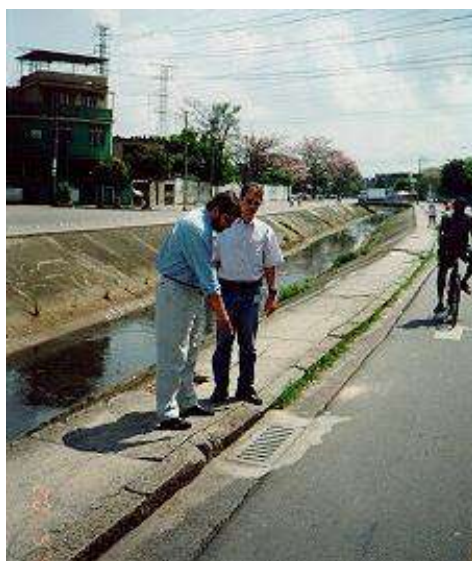
FIGURA 57 EXEMPLO DE POSICIONAMENTO CORRETO DE GRELHA NA CICLOFAIXA NO JARDIM DAS AMÉRICAS, NO RIO DE JANEIRO/RJ
