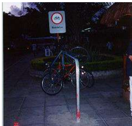
FIGURA 100 SUPORTE TIPO CAVALETE OU HASTE, ONDE AS BICICLETAS FICAM PENDURADAS
