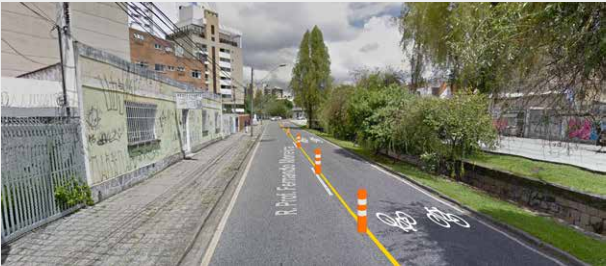
Figura 25 – Simulação de ciclofaixa bidirecional provisória em Curitiba em via de 40 km/h. Fonte: adaptado de Google Street View.
