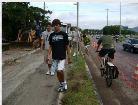
Ciclovía da Av. Beira Mar Norte em obras, bairro Trindade
