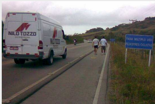
Exemplo de "Via Sinalizada" Via Sinalizada da Tapera , bairro de mesmo nome
