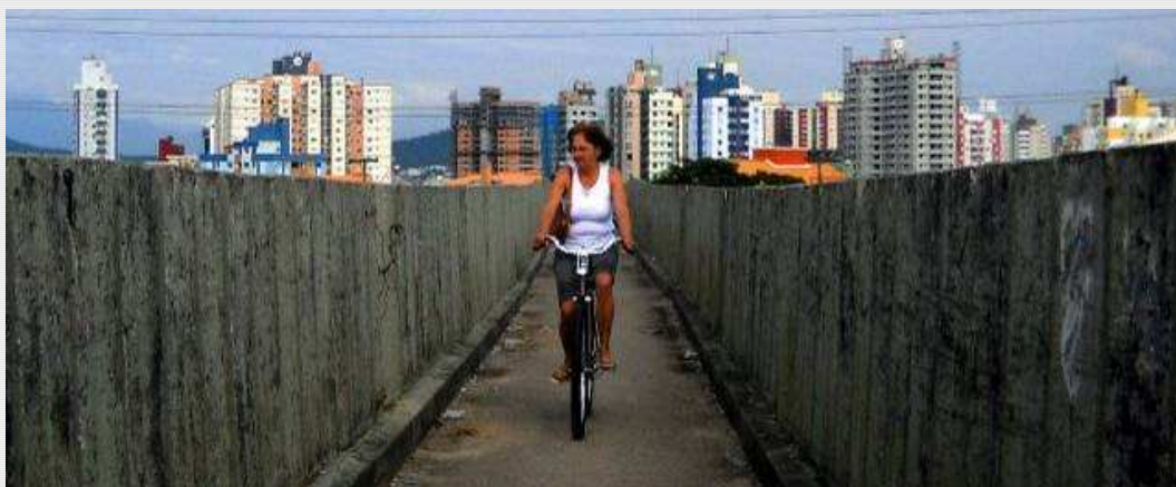
Passarela sobre a BR 282 Via Expressa , bairro Monte Cristo
