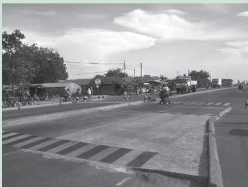
As duas áreas levantadas são instaladas, de cada lado da ilha central, para diminuir a velocidade dos veículos antes da faixa de pedestres.
