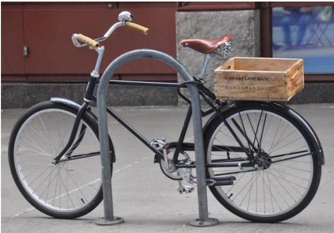
Figura 5. Estacionamiento bicicletas tipo U-invertida empotrado al suelo
