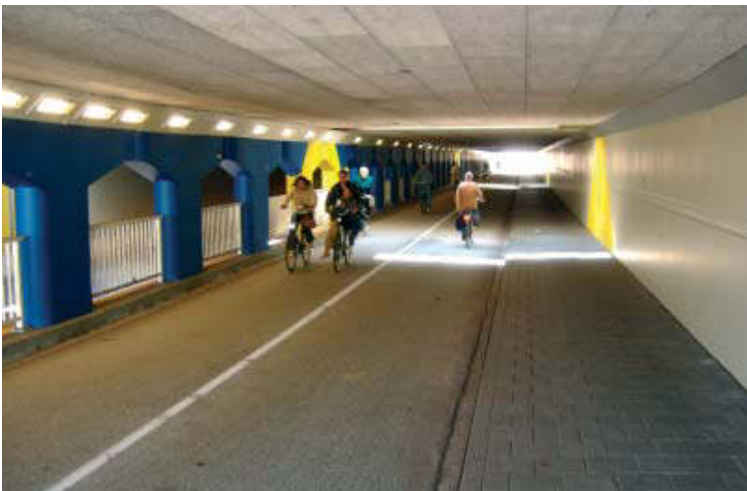
Van Karnebeek tunnel
