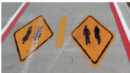
**PASSEIO COMPARTILHADO** foi o primeiro tipo de linha implantada em Curitiba. Espaços compartilhados com pedestres, com acabamento asfáltico. Largura média: 1,5m.
