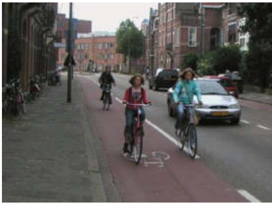
Figura 21: ciclofaixa junto a calçada, em via onde é proibido estacionar, Holanda (INTERFACE FOR CYCLING EXPERTISE, 2009, p. 84)
