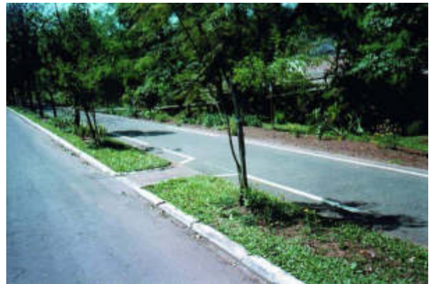
Figura 26: detalhe de acesso à ciclovia em Campo Bom, RS (BRASIL, 2001a, p. 115)
