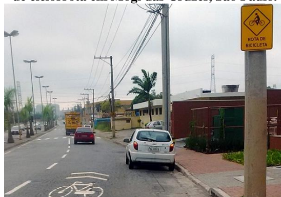
Ilustração 37 - Sinalização vertical e horizontal de ciclorrota em Mogi das Cruzes, São Paulo.
