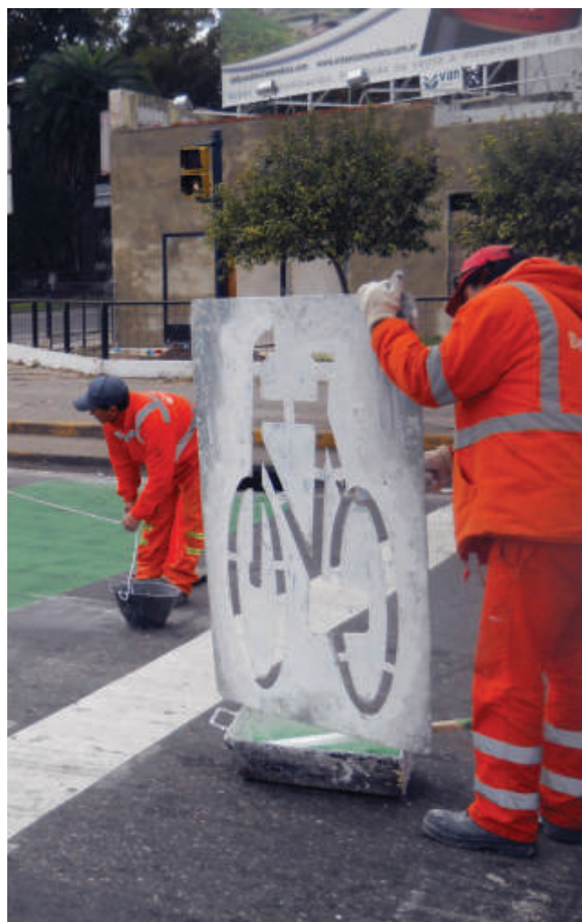
Ciclovía en construcción, Rosario. Fuente: Ente de Movilidad de Rosario.
