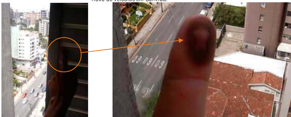
fig. 02 - FULIGEM acumulada em uma semana na veneziana de um apartamento próximo a uma rua de grande fluxo de veículos em Curitiba.
