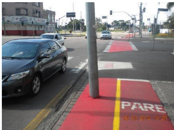
FIGURA 24 – ESTRUTURA PREJUDICANDO A MOBILIDADE PELA BICICLETA
