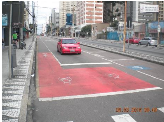
FIGURA 17 – “BICAIXA” NA VIA CALMA – AVENIDA SETE DE SETEMBRO
