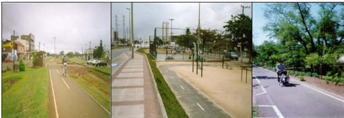
Figura 3.14 – Aplicação de Pavimentos Betuminosos (GEIPOT, 2001)
