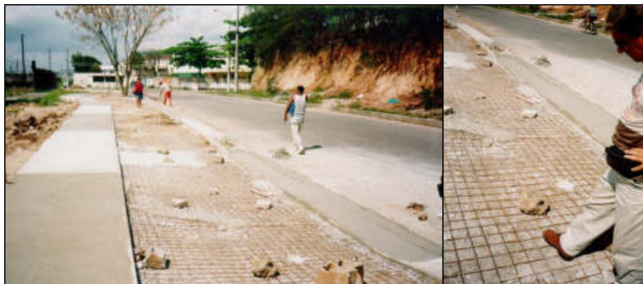
Figura 3.5 – Reforço da base do pavimento em área de cruzamento de veículos sobre a ciclovia em construção em Campo Grande/Rio de Janeiro (GEIPOT, 2001)
