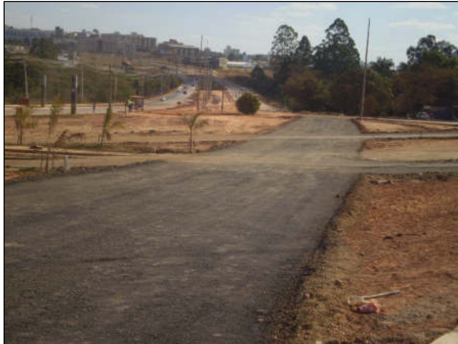
Figura 5.2 – Ciclovia da DF-005 próximo ao Varjão (em andamento)
