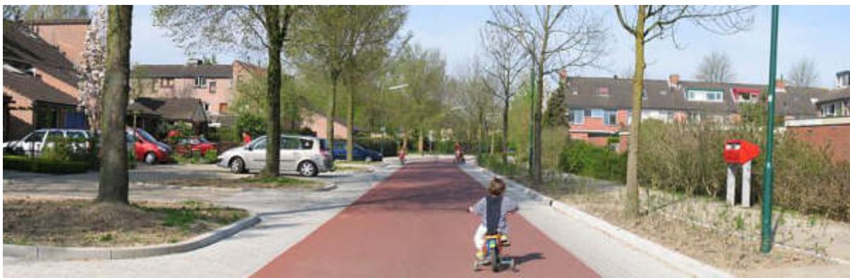
Figura 23: Medida de moderação de tráfego em Houten, Holanda.
