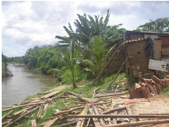
Figura 04 - Casas destruídas no leito do rio Maranguapinho no bairro Bom Sucesso nas chuvas no período março/2006.
