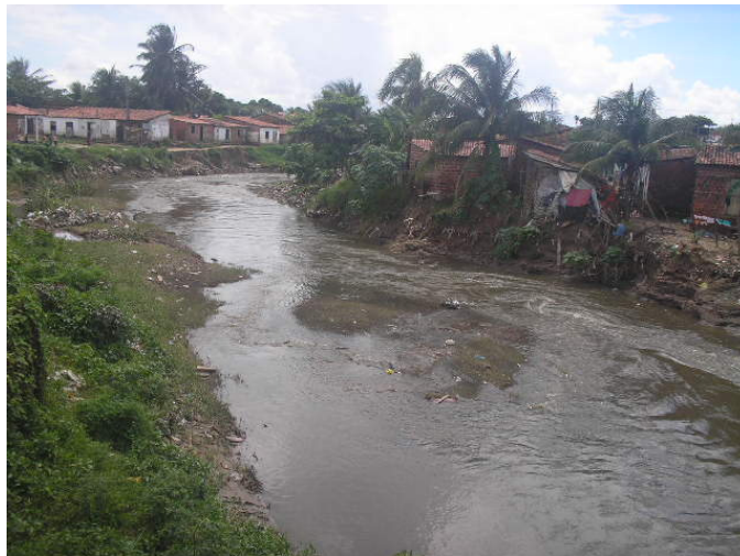
Figura 02 - Casas em área de risco no rio Maranguapinho, no bairro Genibaú em Fortaleza - CE.
