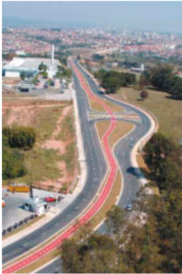
Figura 28. Ciclovias no canteiro central ao longo de avenida em Sorocaba. Foto: Prefeitura de Sorocaba.
