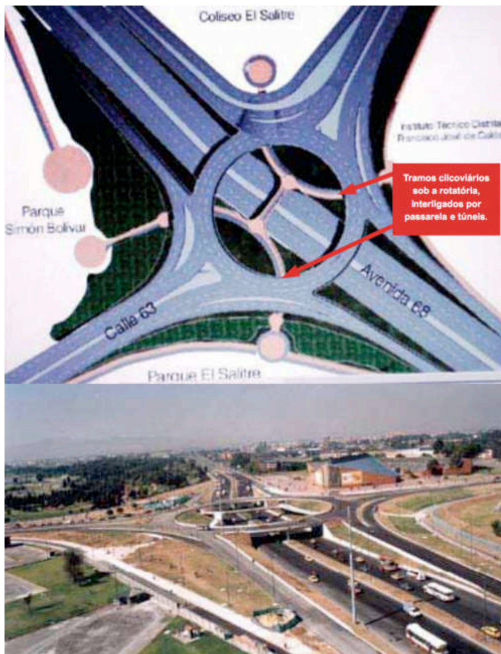
Figura 15: Interseção da Avenida 68 com a Rua 63 com três níveis, sendo o último deles uma rotatória e o segundo passarelas cicloviárias. Bogotá – Colômbia Fonte: Prefeitura Municipal de Bogotá, 2003, apud Bicicleta Brasil (2007, p. 142)
